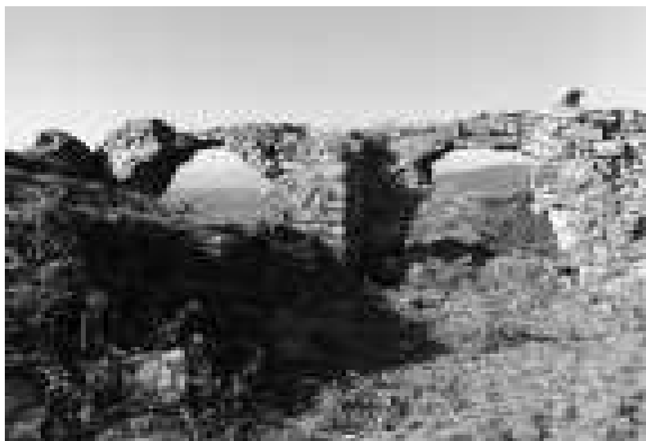
Fig. 13 – Perdifumo, ruderi del monastero di Sant'Arcangelo, area del chiostro
